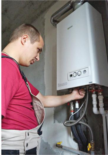
16. Проверка электрических присоединений и подключение котла к электросети.
